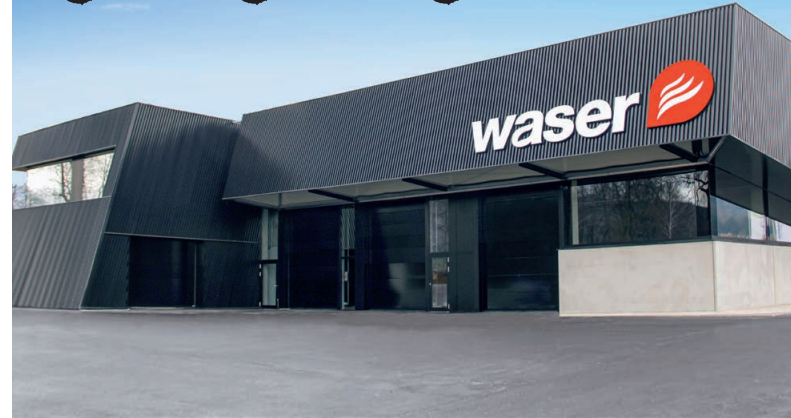
Bereits im Februar 2021 wird das neue Waser-Gebäude bezogen.
